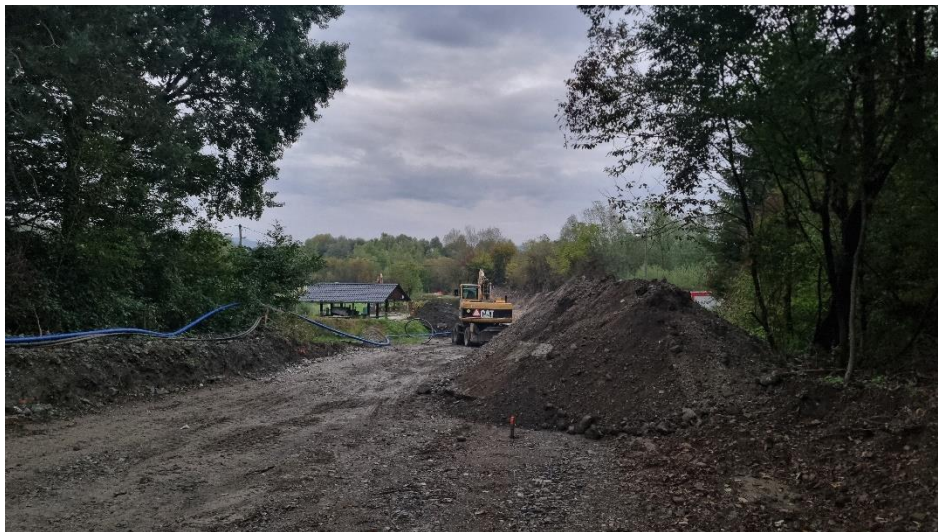
Slika 3: Pogled na ribnik, kjer sedaj gradijo cesto (lasten vir)
